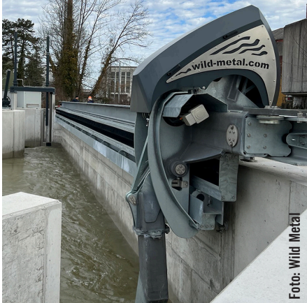
Die Südtiroler Wild Metal GmbH war für die Ausführung der hydromechanischen Gewerke bei der Sanierung des Emmenwehr zuständig.
